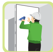
6. ติดตั้ง C-Stud ส่วนที่เหลือ จากนั้นนำแผ่นยิปซัม เอส ซี แอล ขอบลาด ความหนา 12 มม. ไปติดตั้งกับโครงคร่าวที่ได้วางไว้แล้ว
