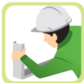
2. บริเวณที่เป็นช่องประตูให้ตัด U-Track ยาวเพิ่มขึ้น 30 ซม. เพื่อเตรียมผนังขึ้นรับเหล็ก C-Stud
